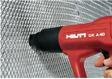
Çelik filelerin betona sabitlenmesi
