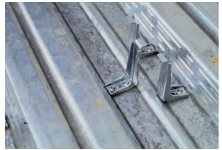
Kompozit döşemelerde HVB kesme kamasının DX 76 ile çelik profile sabitlenmesi
