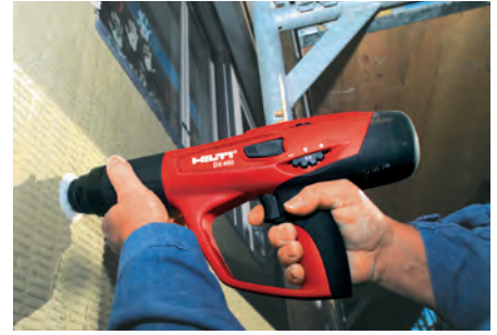
Isı yalıtımında izolasyon dübellerinin sabitlenmesi
