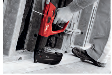
Ahşabın betona sabitlenmesi
